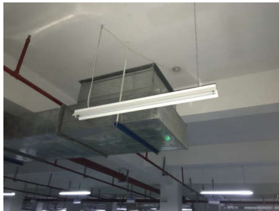
地下车库排风装置进气口
