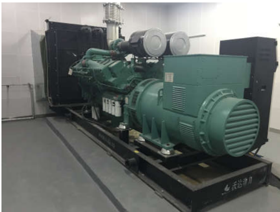
备用发电机减震基座
