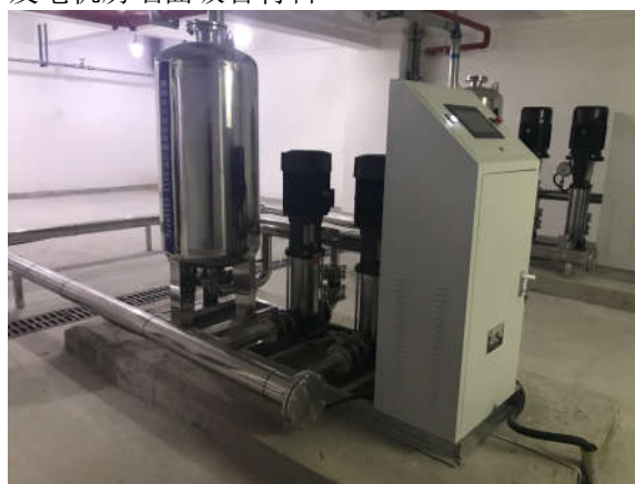
水泵下设有的减震基座
